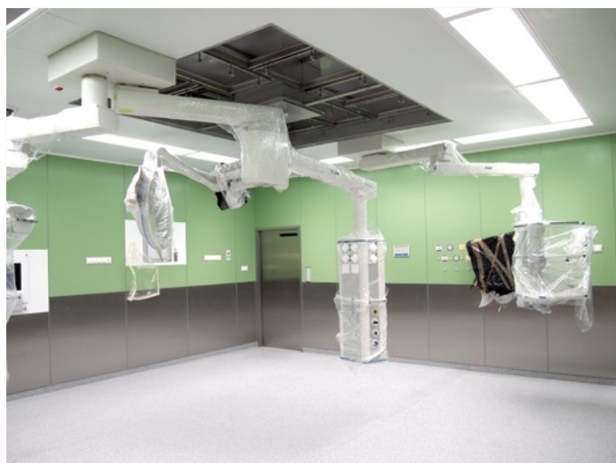
Sala operacyjna na nowym bloku
