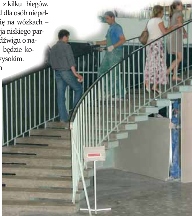
Schody nie będą jedyną drogą na wysoki parter
