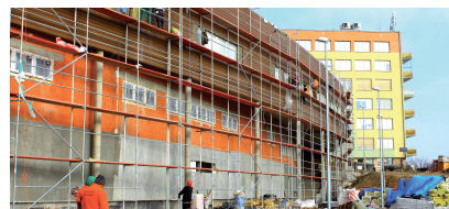
Prace elewacyjne dobiegają ku końcowi.
