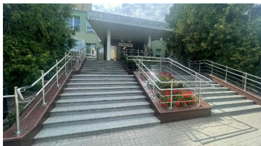
Zdjęcie nr 4: Schody zewnętrzne
