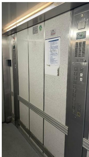
Zdjęcie nr 17: Komunikacja pionowa - kabina windy
