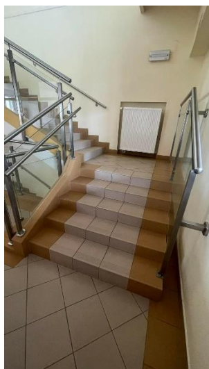
Zdjęcie nr 18: Komunikacja pionowa - wewnętrzna klatka schodowa
